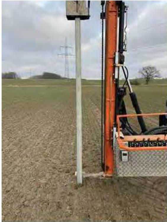
Figure 16 : Battage des pieux, source EnergieKontor
