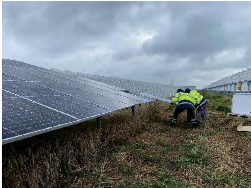
Figure 23 : Mise en place des modules sur les structures, source EnergieKontor
